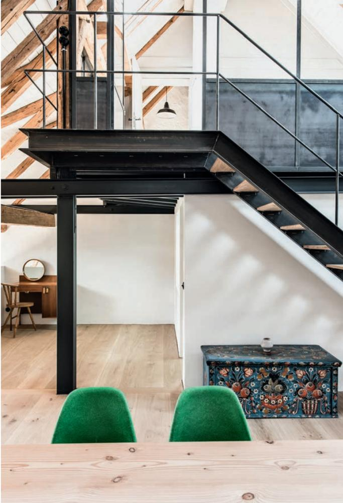
**Links:** Maßgefertigte, bis zu sieben Meter lange, geölte Eichendielen sowie kleinere neue Einbauten prägen das Raumgefüge. Schwarze Stahlbauteile vervollständigen die Konstruktion des sandgestrahlten Holztragwerks lediglich dort, wo es unausweichlich war
